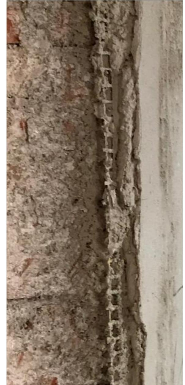
Il rinforzo strutturale eseguito mediante rete metallica elettrosaldata connessa alle murature con elementi in acciaio presenta un importante “punto debole” che può causare gravi danni agli intonaci strutturali ovvero **la corrosione del metallo**. L'impiego di malte a comportamento pozzolanico è fondamentale in questo tipo di intervento.
